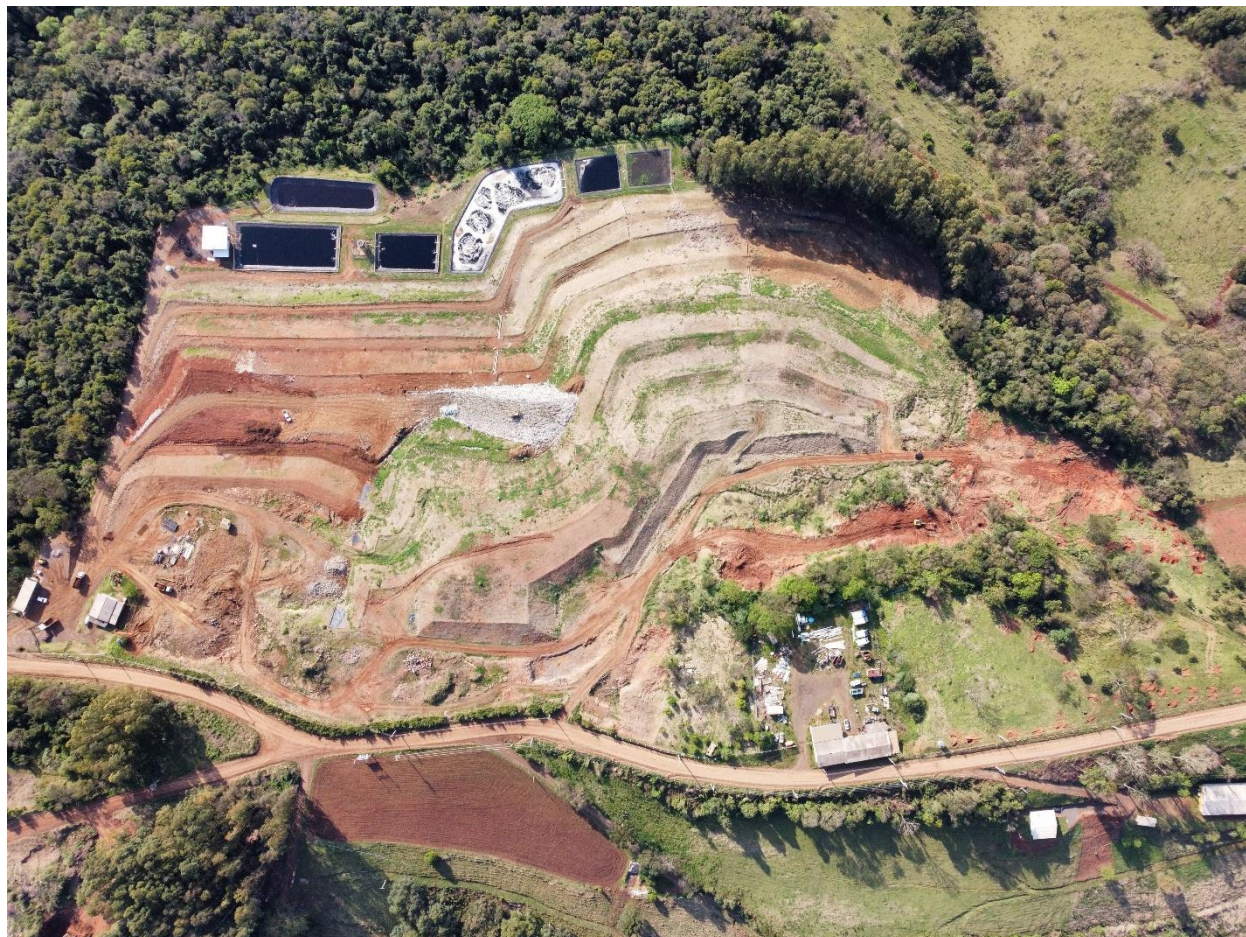
Figura 194 - Aterro de Ipumirim/SC
