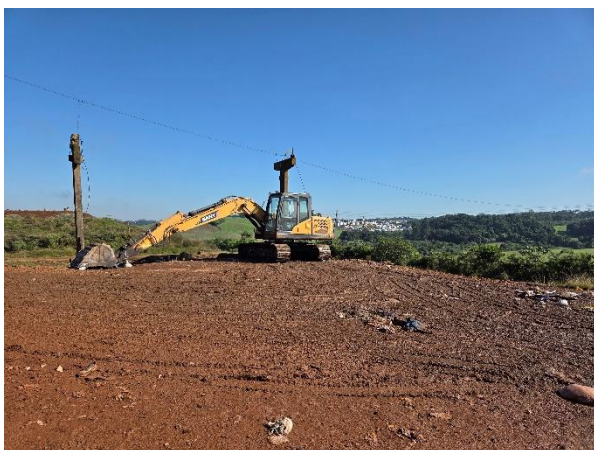
Figura 164 - Escavadeira da Área de Transbordo
