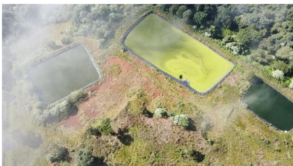
Figura 193 - Lagoas de Acúmulo de Lixiviado
