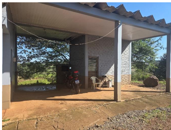
Figura 180 - Instalações do Aterro Sanitário
