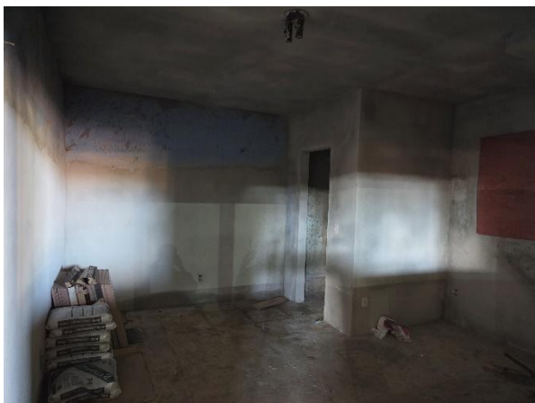
Figura 32 - Locais em Reforma da Associação Arcan
