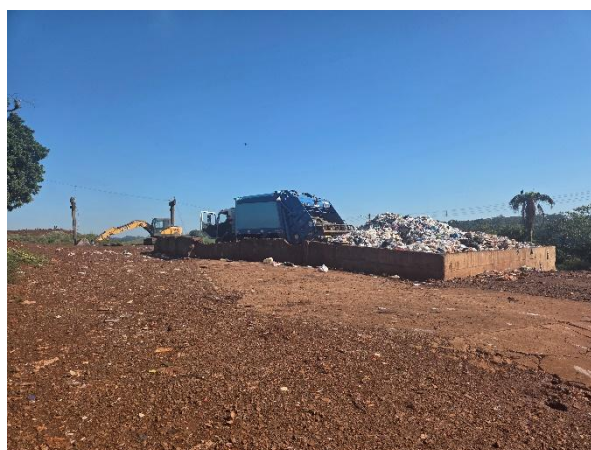
Figura 173 - Caminhão Descarregando na AT
