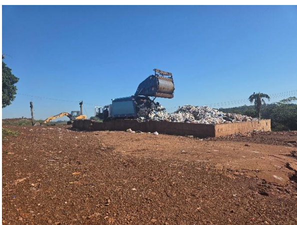
Figura 172 - Caminhão Descarregando na AT
