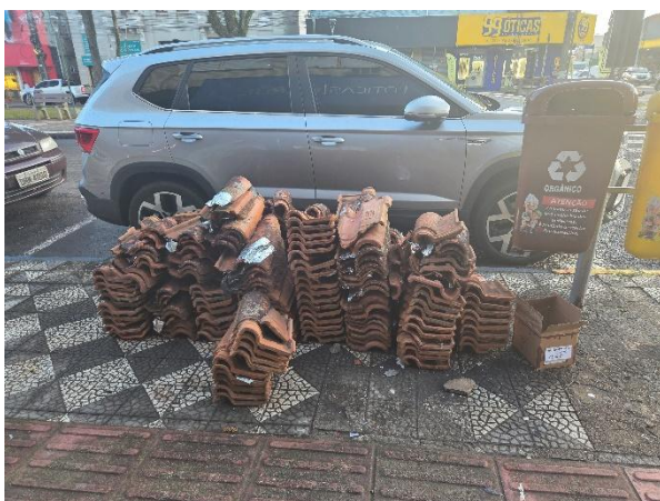
Figura 251 - Descarte inadequado de RCC
