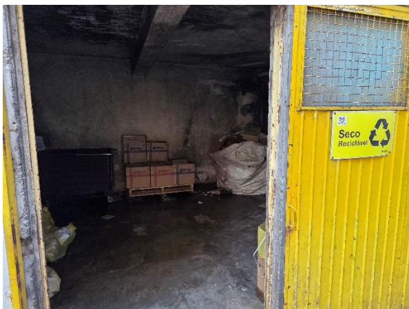
Figura 245 - Área de Armazenamento de Resíduo Reciclável no Hospital Regional
