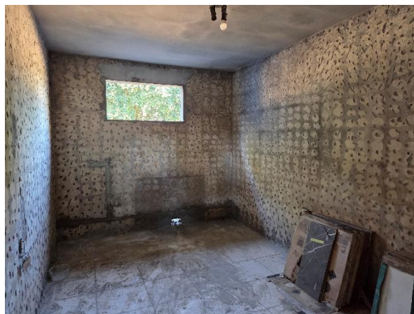
Figura 33 - Locais em Reforma da Associação Arcan
