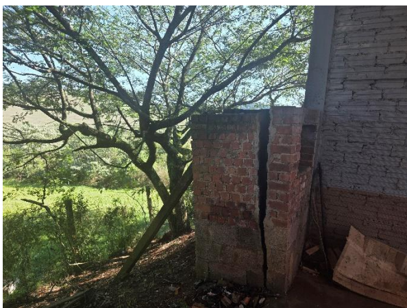
Figura 181 - Instalações do Aterro Sanitário
