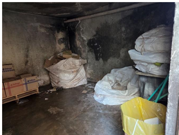
Figura 246 - Área de Armazenamento de Resíduo Reciclável no Hospital Regional
