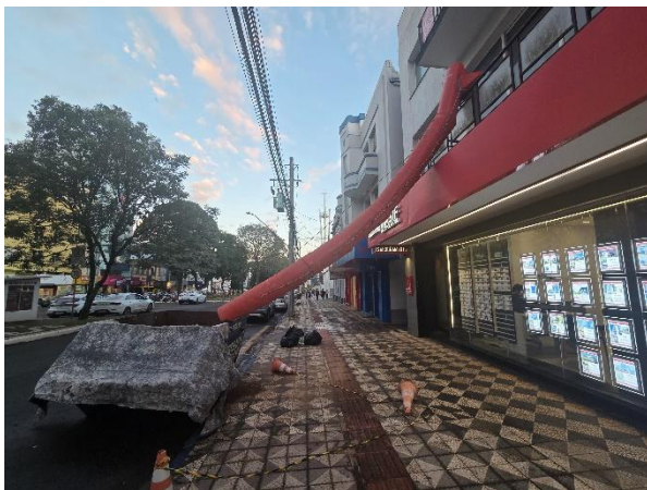
Figura 249 - Descarte adequado de RCC
