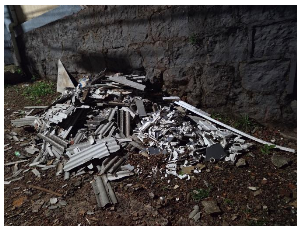
Figura 252 - Descarte inadequado de RCC
