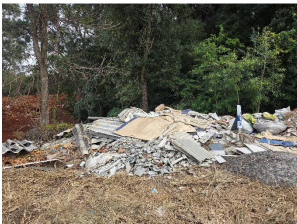
Figura 253 - Descarte inadequado de RCC
