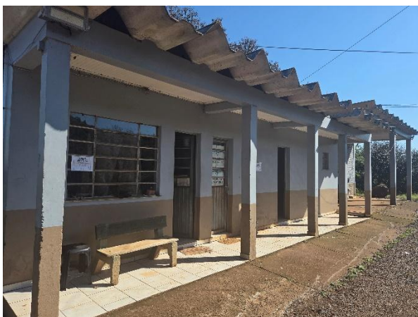
Figura 179 - Instalações do Aterro Sanitário
