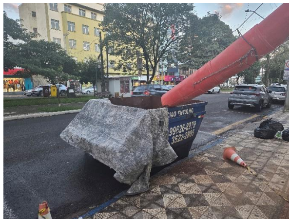
Figura 250 - Descarte adequado de RCC
