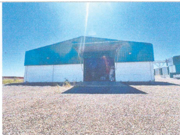
Foto 02: Vista frontal do pavilhão da empresa AGRICOOP.
