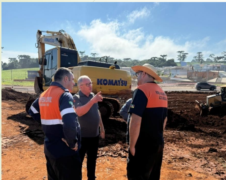
Execução obra estratégica RS/331
