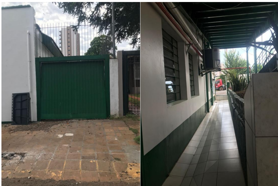
Imagens 45 e 46: acesso para abastecimento e carga e descarga pela Rua Torres Gonçalves / acesso pela lateral do restaurante, pela rua Severiano de Almeida
