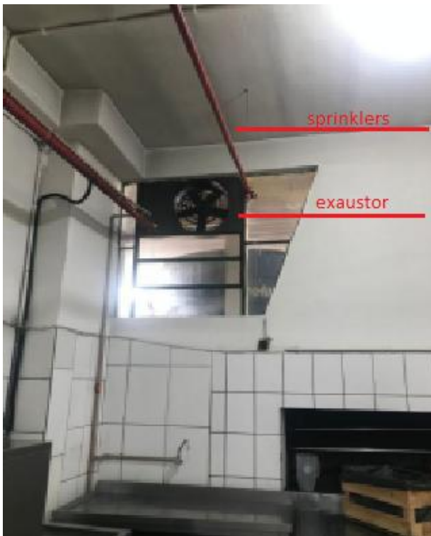
Imagem 37: churrasqueira; exaustor e sistema de sprinklers na churrasqueira
