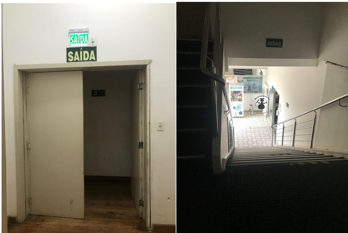
Imagens 52 e 53: salão de baile - saídas de emergência para acesso à escada, com antecâmara / escada acesso à rua
