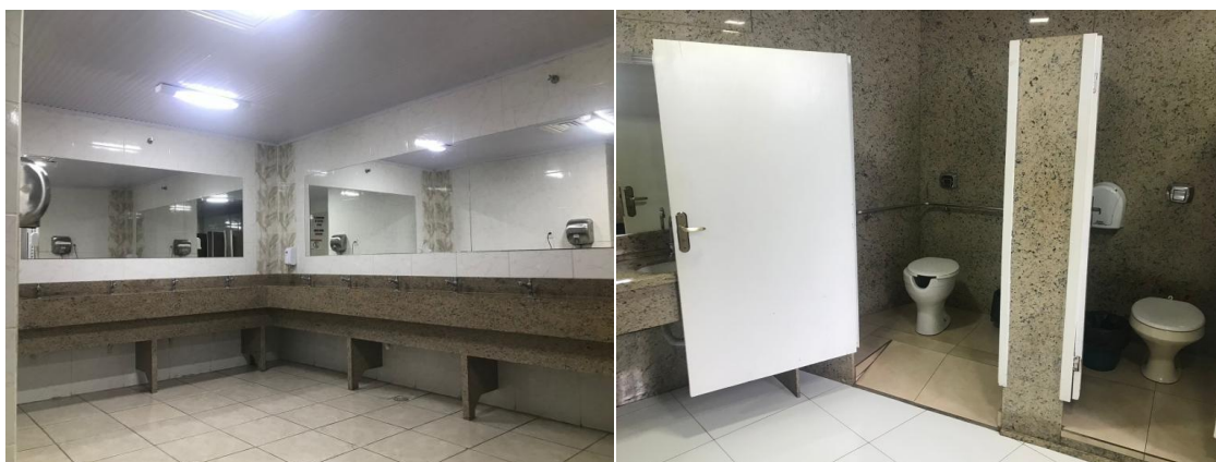
Imagens 13 e 14: banheiro feminino com banheiro para PCD
