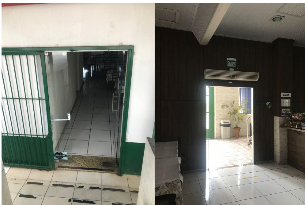
Imagens 59 e 60 : restaurante - porta acesso pelo estacionamento / porta principal, acesso pela Rua Severiano de Almeida
