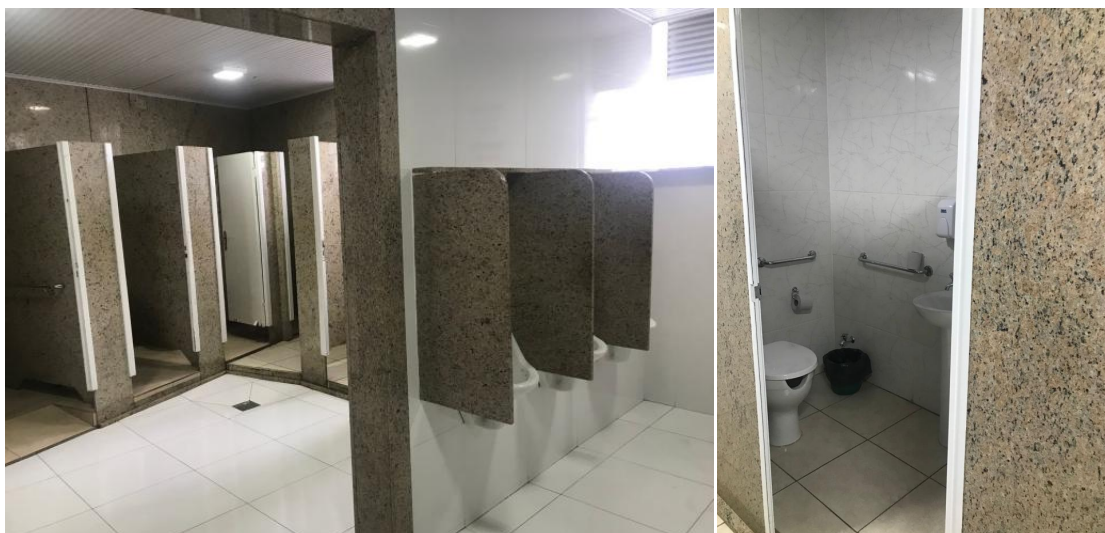
Imagens 11 e 12: banheiro masculino / banheiro PCD dentro do banheiro masculino
