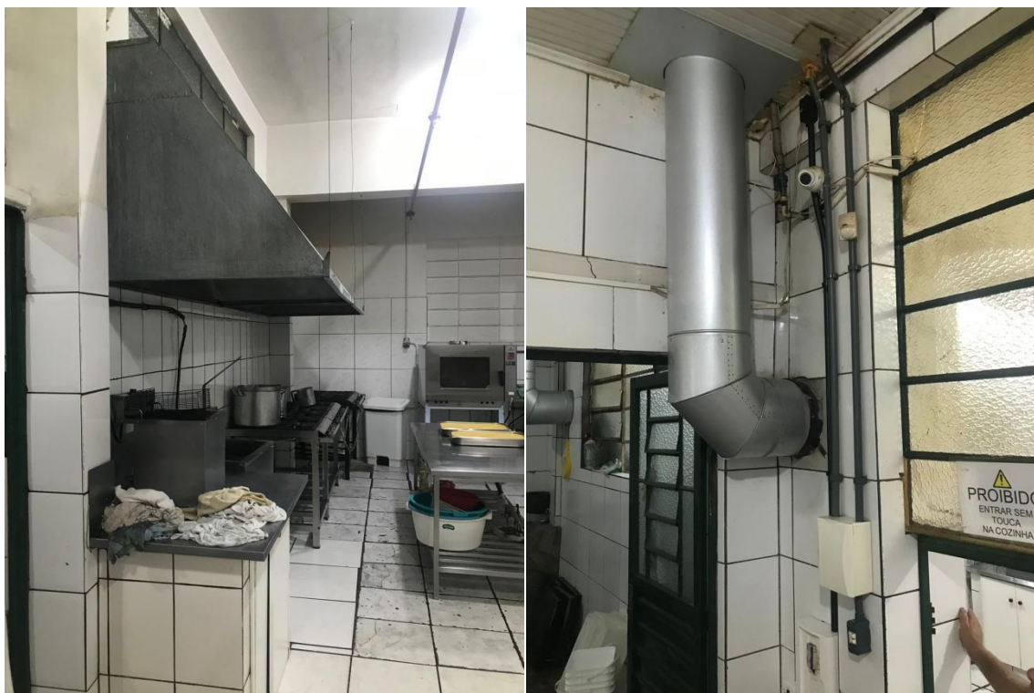
Imagens 30 e 31: cozinha - espaço de preparo de alimentos; saída das coifas para fora do telhado Fonte: arquivo próprio / janeiro de 2022
