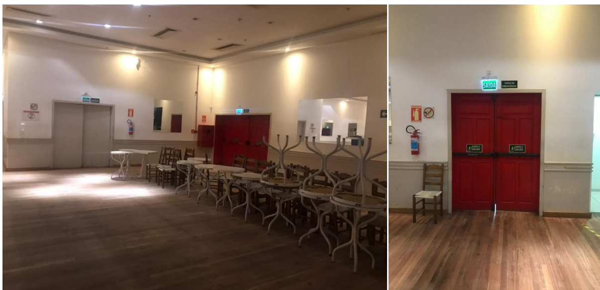
Imagens 49 e 50: salão de baile - saídas de emergência sinalizadas, sprinklers no forro, hidrante
