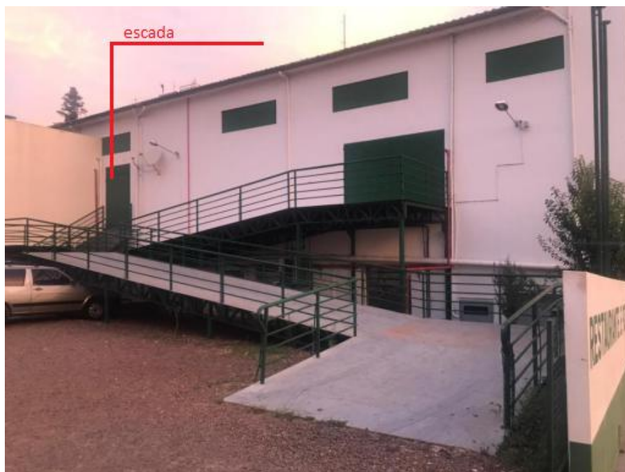
Imagem 54: salão de baile - saídas de emergência vista do estacionamento, com acesso por escada e rampa
