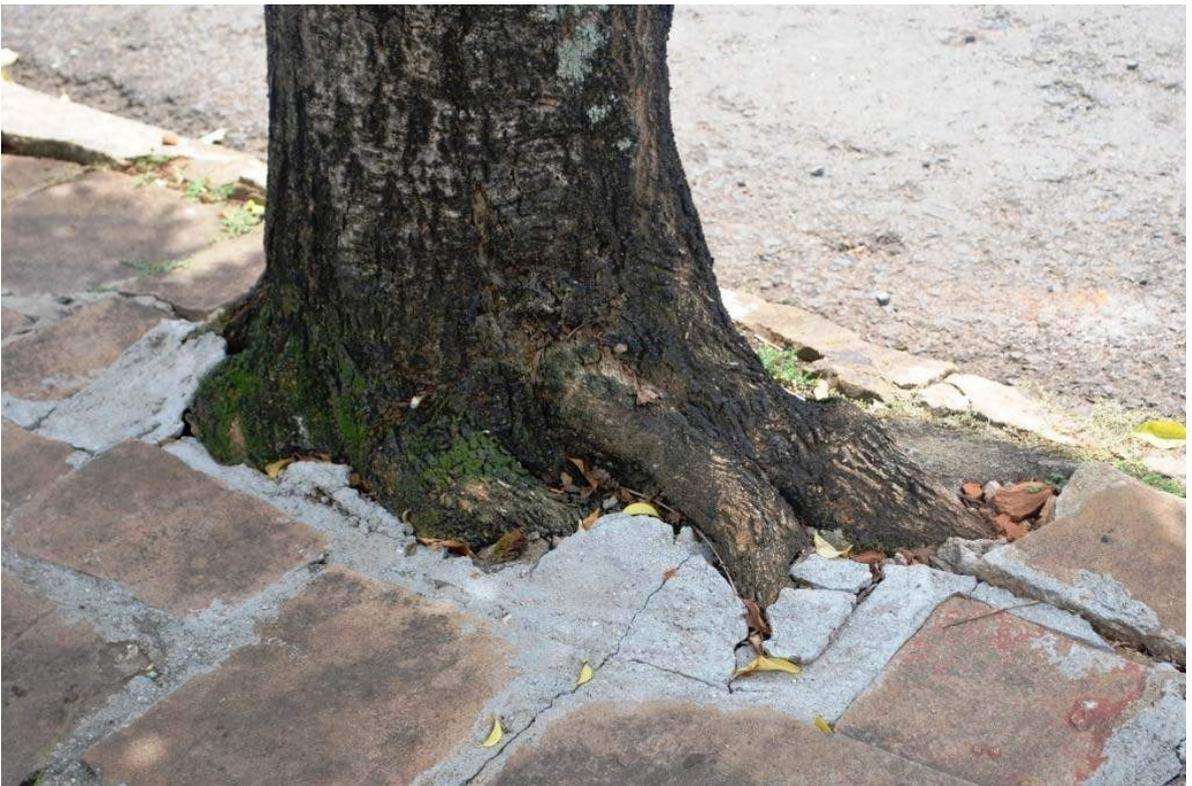
**Figura 32.** Afloramento de raiz proveniente da inexistência de área livre para crescimento do indivíduo (detalhe para a área cimentada).
