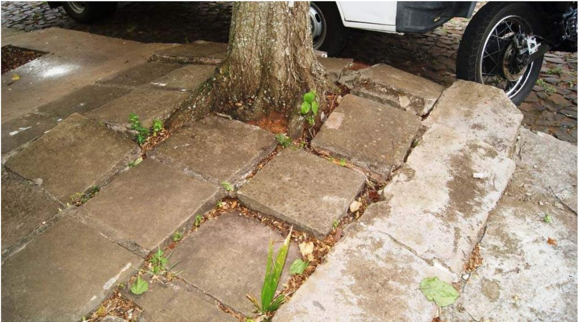
**Figura 31.** Afloramento de raiz causando danos à calçada.
