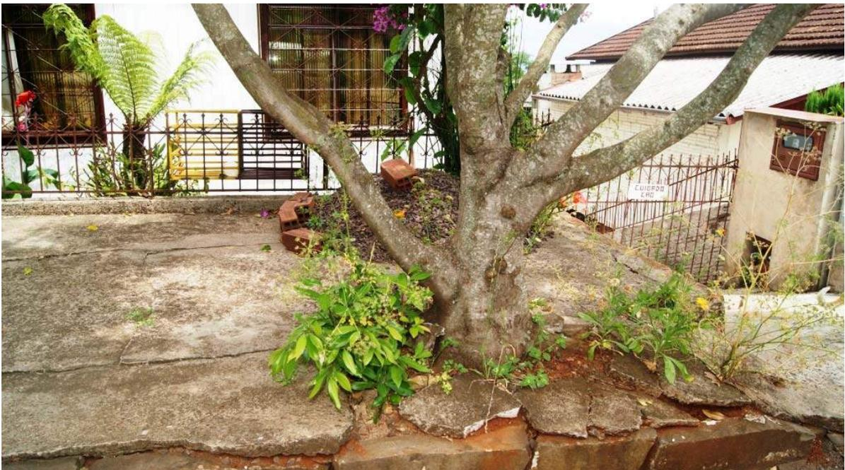
**Figura 30.** Afloramento de raiz causando danos à calçada.
