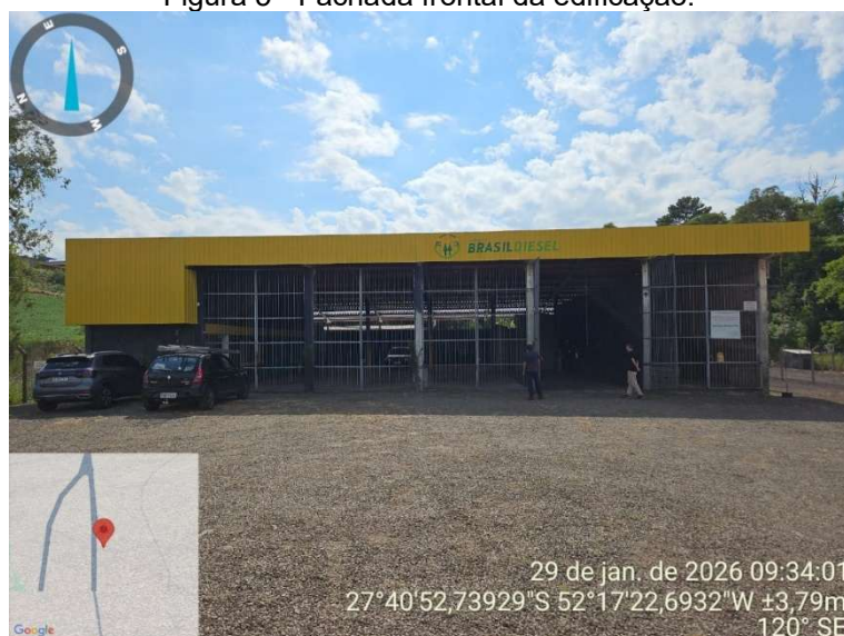
Figura 5 - Fachada frontal da edificação.
