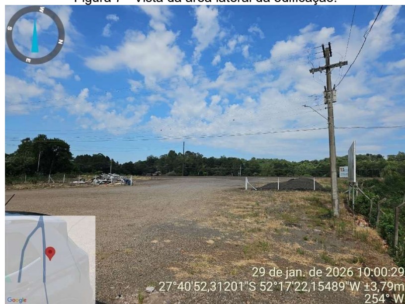
Figura 7 - Vista da área lateral da edificação.
