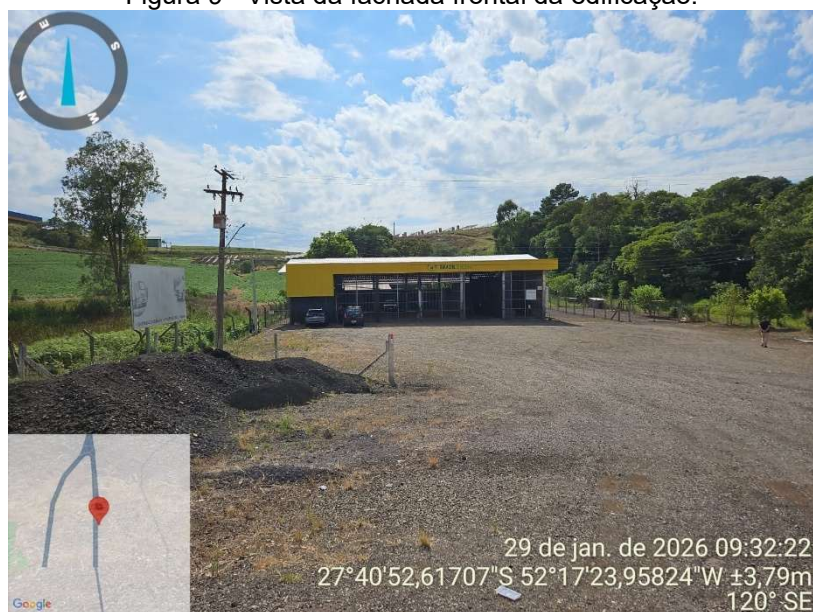
Figura 9 - Vista da fachada frontal da edificação.
