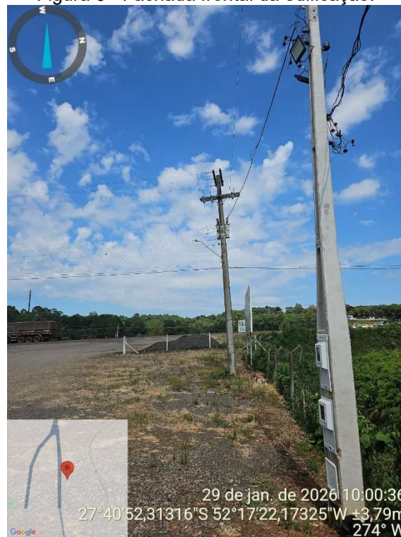
Figura 6 - Fachada frontal da edificação.
