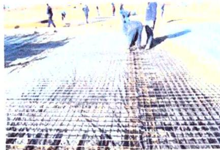
Preparação da armadura e das barras de transferência
