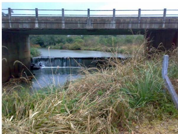
Figura 26: Barragem do reservatório formado pelo rio Campo.
