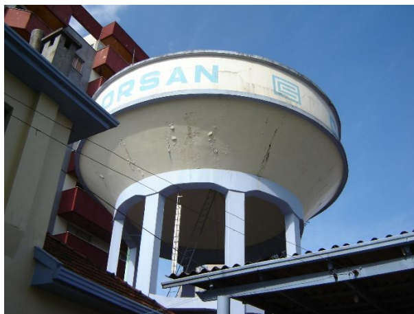
Figura 93: Reservatório elevado de 150 m 3 da Rua Portugal.
