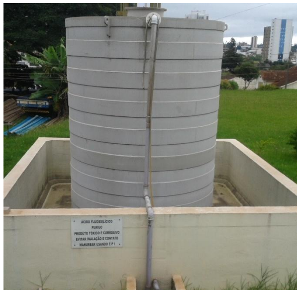
Figura 53: Depósito de Ácido Fluorsilícico.
