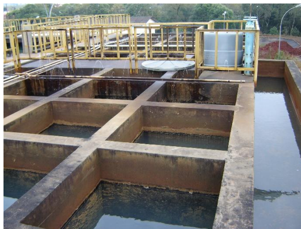
Figura 57: Floculadores hidráulicos.
