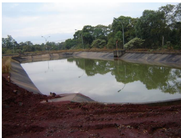
Figura 60: Lagoa de decantação do lodo da ETA 2.
