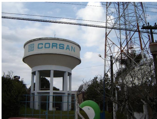
Figura 95: Reservatório elevado de 250 m 3 da Rua Soledade (RBS).
