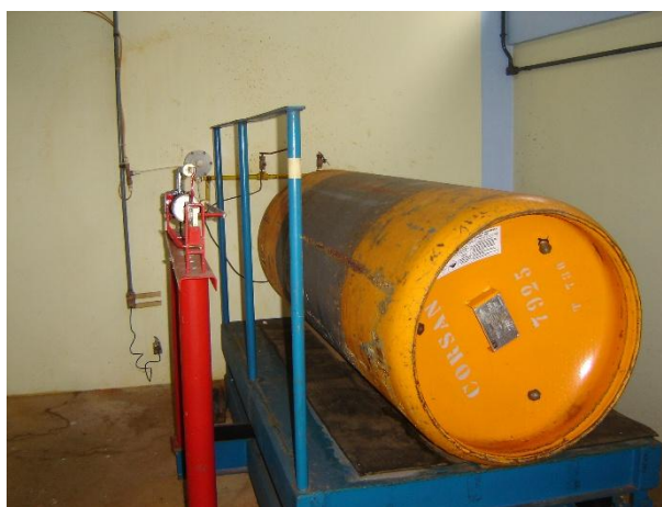
Figura 69: Cilindro de 900 kg de cloro.
