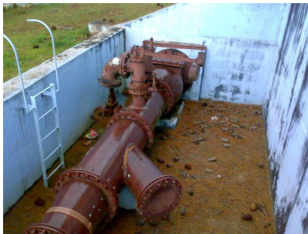
Figura 38: Tubulação de Ø 350 mm que transporta água bruta para a ETA 2 e o sistema de alívio de transiente hidráulico.
