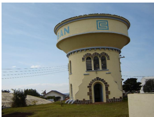
Figura 91: Reserv. elevado de 250 m 3 e apoiado de 2.000 m 3 na ETA 2.
