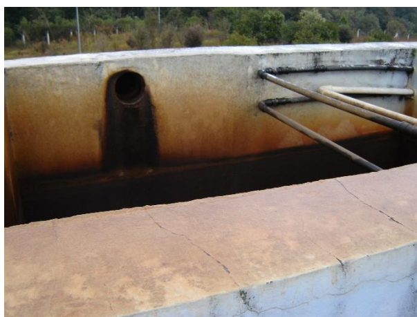
Figura 63: Chegada da água da lagoa na entrada da Calha Parshall.
