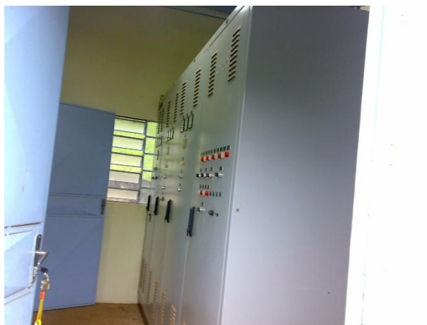
Figura 76: Quadro de comando dos motores partida por soft-start.
