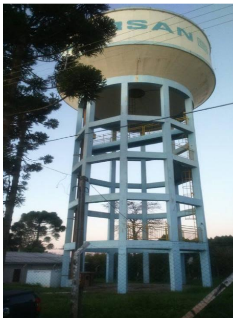
Figura 97: Reservatório elevado de 500 m 3 .
