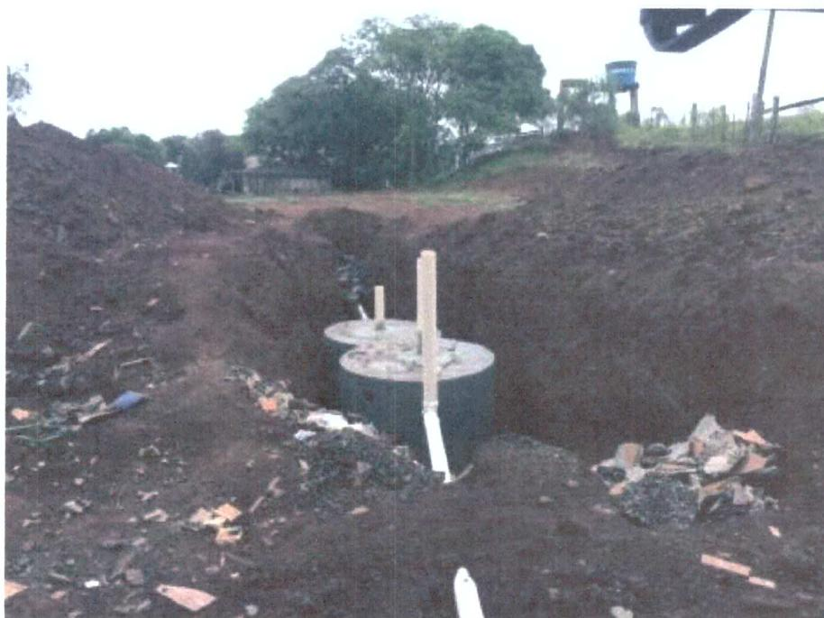
Figura 17 - Instalação do Sistema Fossa, Filtro e Sumidouro.
