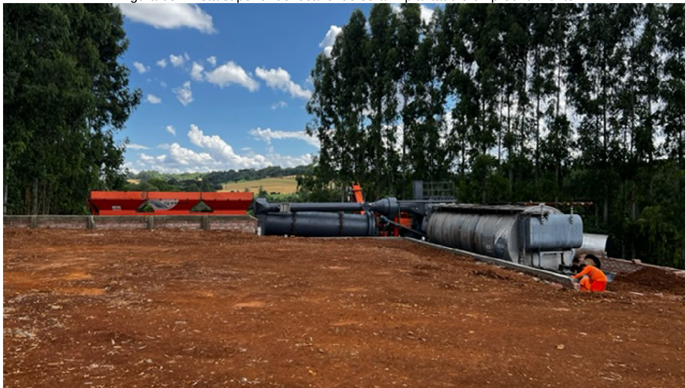
Figura 03 - Vista superior do local onde será implantado o empreendimento
