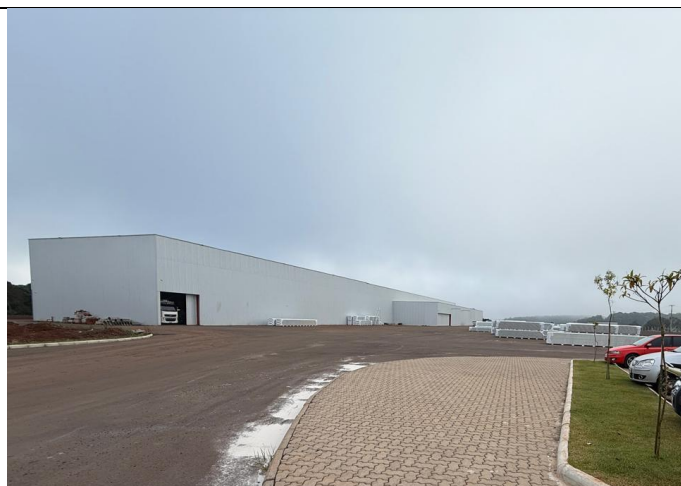
Foto 03: Vista geral do pavilhão industrial.
