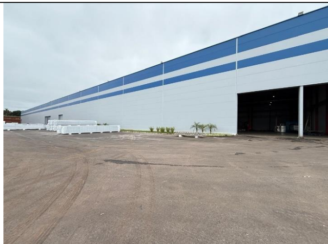
Foto 01: Vista geral de um dos pavilhões industriais.
