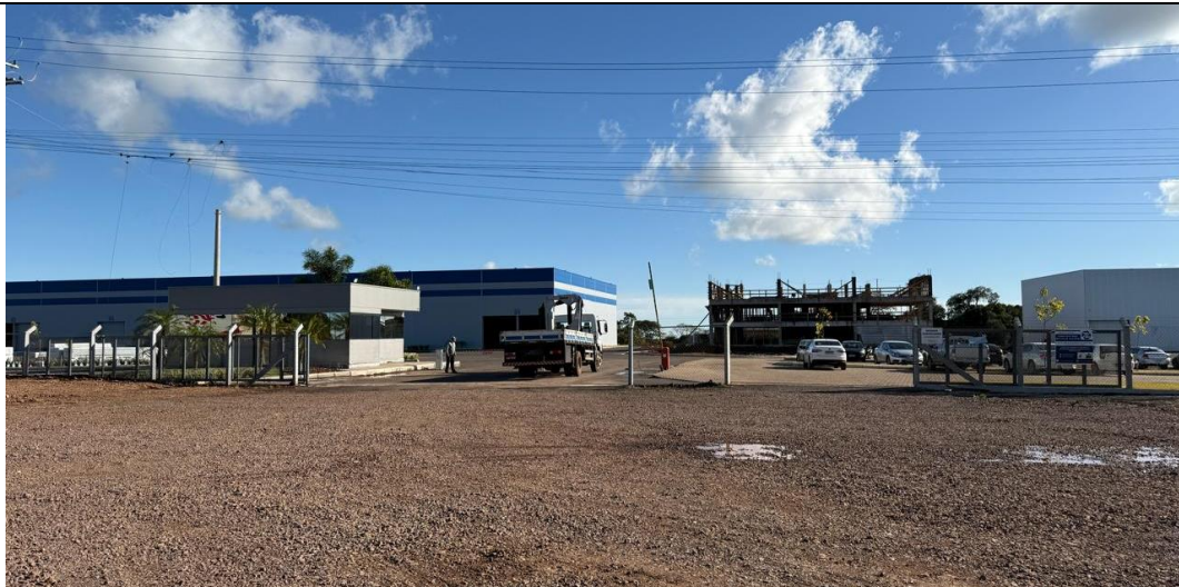
Foto 07: Vista do portão de acesso à empresa.
